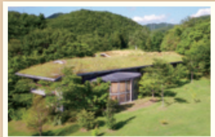
景観に配慮された博物館。この屋根にも土をのせています。
